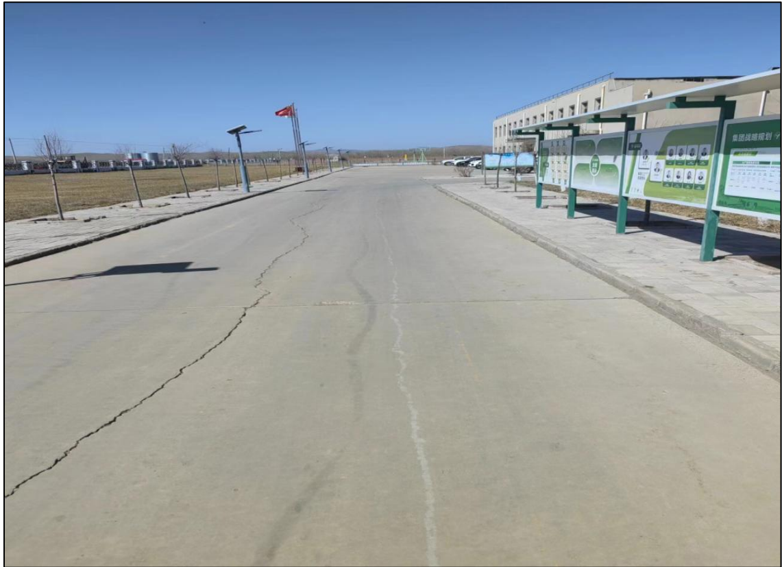
图 3-1 厂区道路硬化
